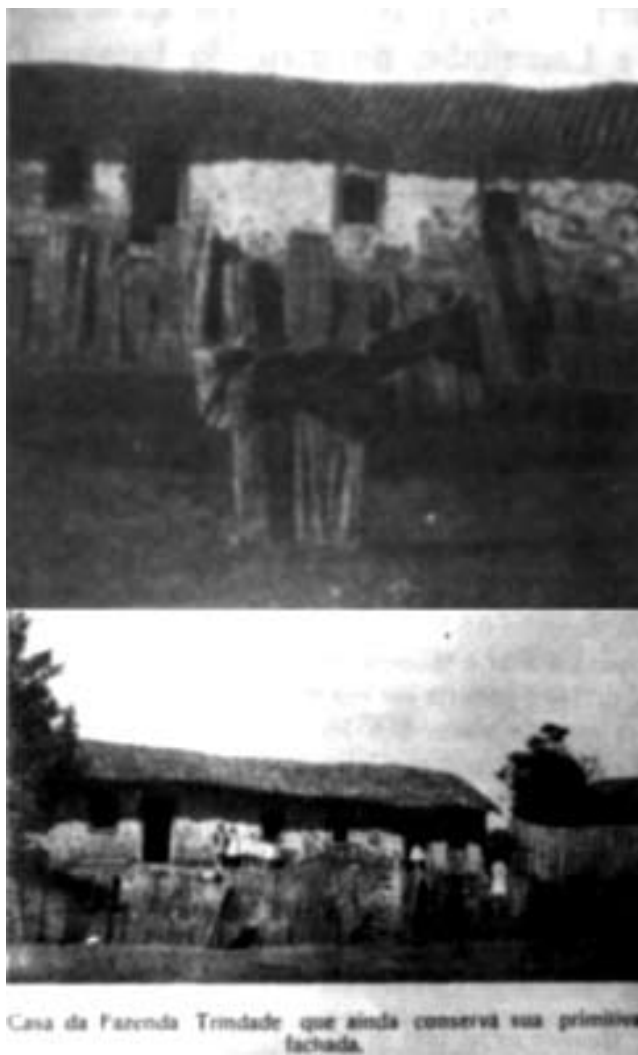
Figura 19. Aspectos da antiga Fazenda Trindade, na região de Palmas, do fazendeiro Pedro Ribeiro de Souza. Ela conservava, em 1936, a fachada da época de sua construção. Podemos observar sua cobertura com telhas goivas, as paredes de taipa e uma forte paliçada de madeira destinada a conter os atagues dos índios por ocasião da ocupação da região.
