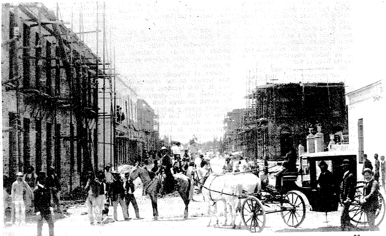
El Barrio Reus al Norte, en plena construcción.
